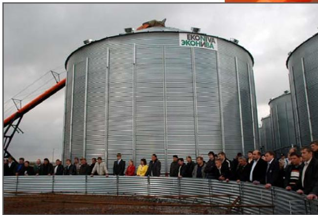
готовлены из высококачественной стали, покрытой специальным сплавом galfan (цинк и алюминий), что дает защиту от коррозии почти в два раза выше, чем обычная "оцинковка".
